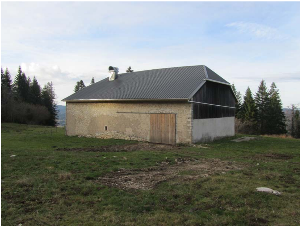
La Grangette vue de l'arrière, guère plus de charme qu'un hangar agricole, mis à part la forme générale tout de même assez typique de l'endroit.
